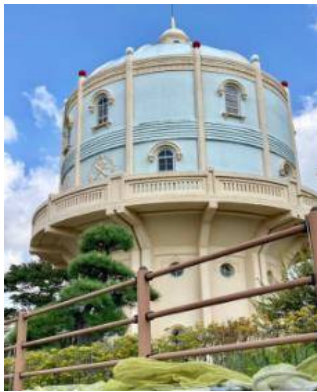
<水戸市水道低区配水塔>
